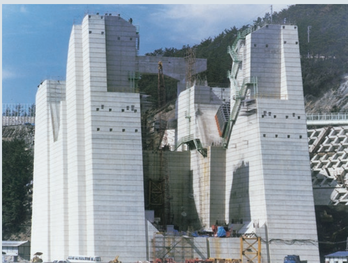
完成したアンカレイジ。（吊り橋のメインロープを地盤にしっかり固定させるための巨大なコンクリートブロック）
