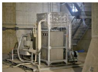
本四高速が開発したケーブル内に乾燥した空気を送る「ケーブル送気システム」は国内外の橋にも採用されています。
