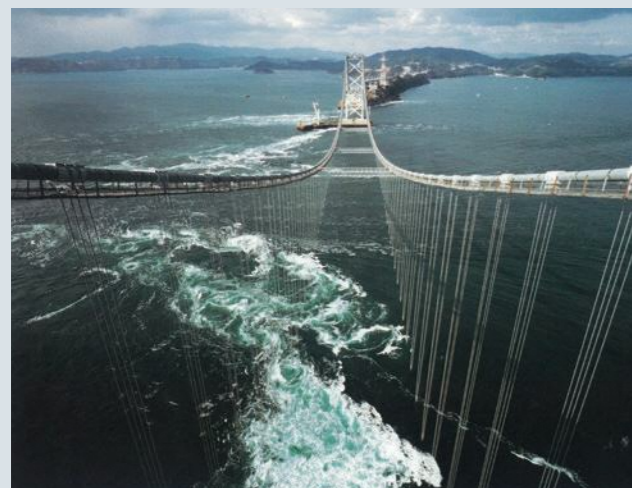
上/主塔をつくるための作業。地上で組み立てた塔頂クレーンを仮設したところ。クレーンの能力は20トンで2基ずつ設置されました。 下/ハンガーロープを吊したケーブル前期工事完了時の全景。吊り橋の外観がイメージできます。
