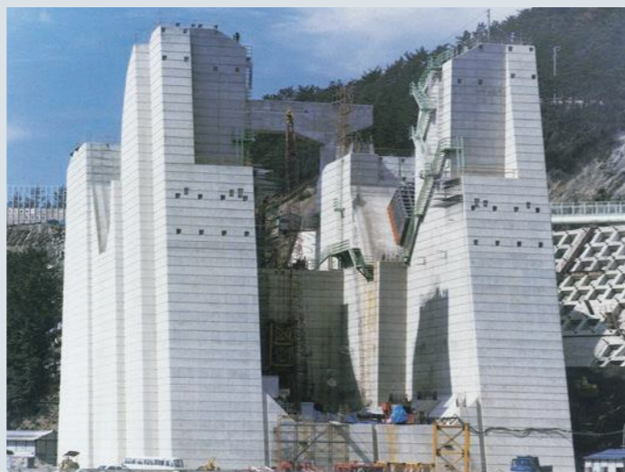
完成したアンカレージ。(吊り橋のメインロープを地盤にしっかり固定させるための巨大なコンクリートブロック)
