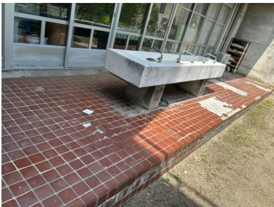
19 1階テラス（小学校側）
