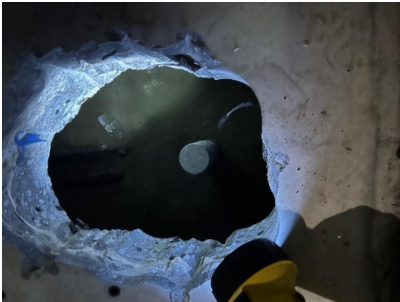
2 2 建物地下（理科準備室の点検口より撮影）
