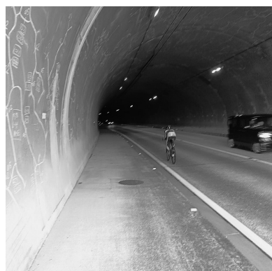
三津トンネル
