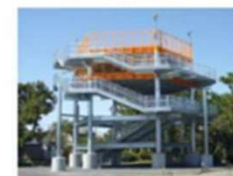
津波避難タワー
