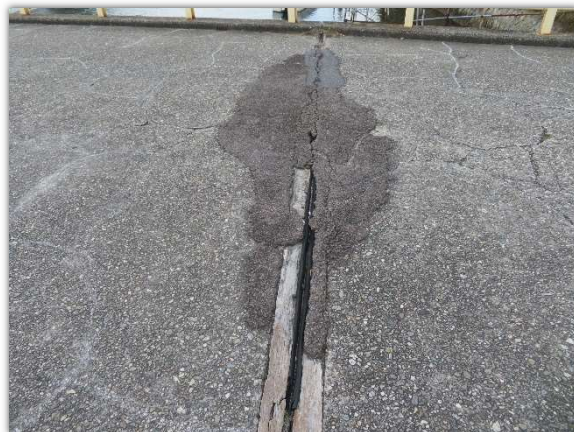
写真 6. 路面の段差
