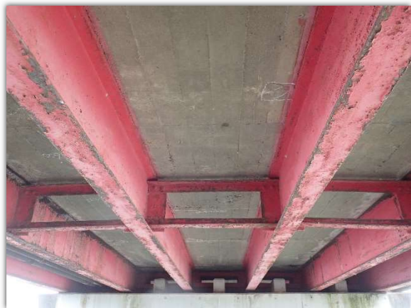
写真 1. 鋼桁の腐食
