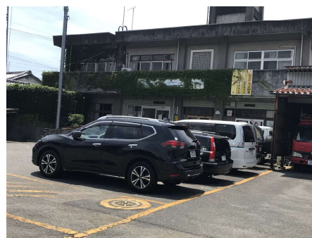
大麻分署（駐車場の動線分離が不十分）
