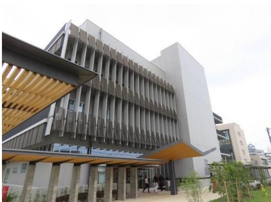
新庁舎は免震構造を採用しており、地震が発生した際には、建物下部の免震ゴムが地震の揺れを吸収し、建物への影響を最小限に抑えることができます。また、外部階段は建物本体に付随する部分と地上に付随する部分に構造が分かれてお
