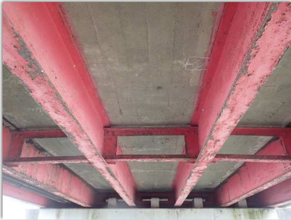
写真 1. 鋼桁の腐食
