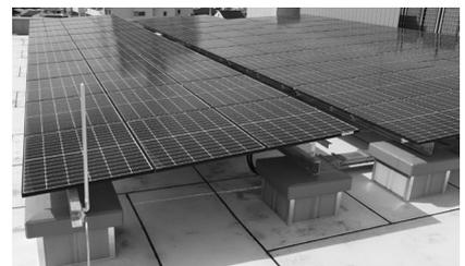
▲屋上に設置する太陽光発電設備。蓄電池も整備するなど、自然エネルギーを利用して消費電力のピークをカット
