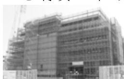
建設が進む新庁舎
