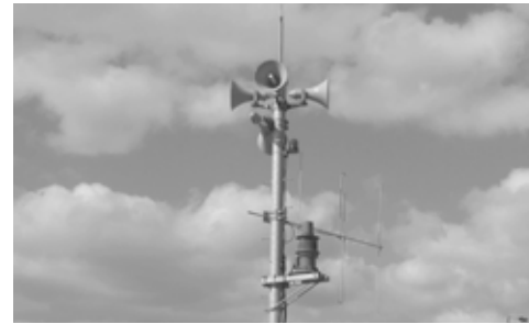
屋外拡声スピーカーと モーターサイレン
