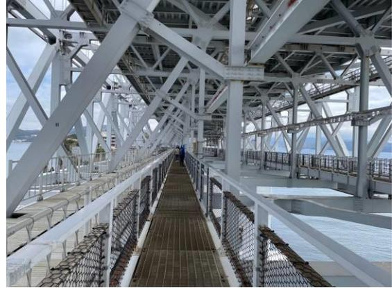
说起大鸣门桥，它的全长有约 1600 米，下方有供维护人员检修大桥时行走的道路。经过报名，有幸参加开放日活动中。进入通道后，呼呼的北风声，轰鸣的潮水声，大桥上汽车声一起灌入耳中。道路距离水面有 40 多米，约有 15 层楼高，可以直接看到奔涌的潮水。之前计划铺设新干线预留的空间将铺设自行车通道，完成后可以骑自行车横渡鸣门海峡。
