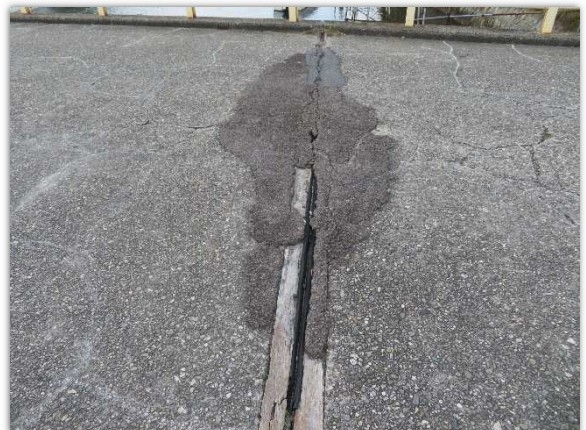
写真 6. 路面の段差
