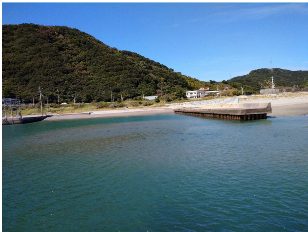
※ 土砂が堆積している亀浦漁港（八木の鼻地区）
