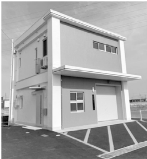
◀ 新築された板東南分団詰所
