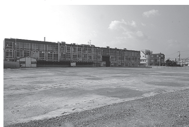
新庁舎建設予定地
