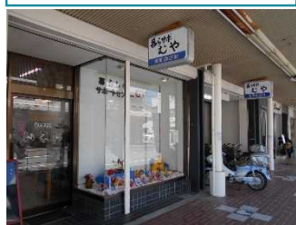
商店街の 空き店舗を利用
