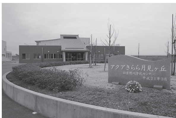
2市4町から運ばれた汚水を一括して処理する 旧吉野川浄化センター（通称：アクアきらら月見ヶ丘）
