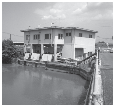
農業用排水機場
