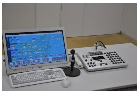
消防本部に設置された無線操作卓
