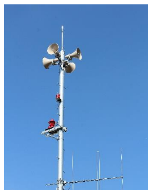
屋外拡声スピーカーとモーターサイレン
