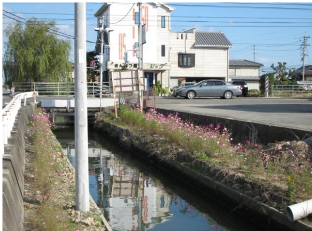
矢倉 矢倉水路沿い
