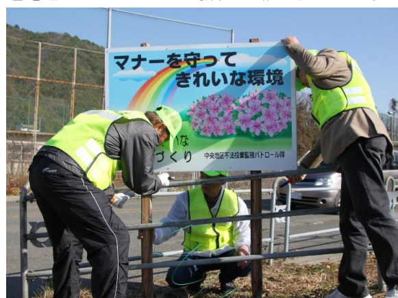
道路沿いのよく目立つ場所に看板を設置します
