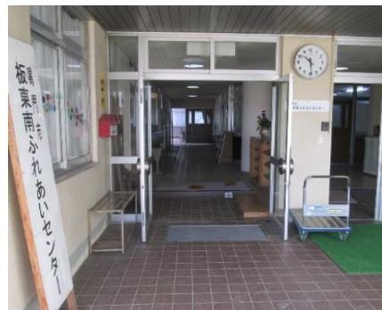
現在、旧川崎幼稚園は「板東南ふれあいセンター」として新たに生まれ変わっています！
