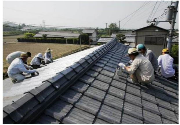
瓦を1枚1枚、ていねいに塗っていきます。
