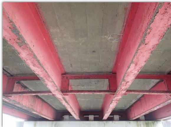
写真1. 鋼桁の腐食
