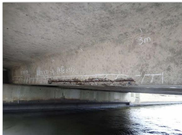
写真3. コンクリート桁の剥離・鉄筋露出
