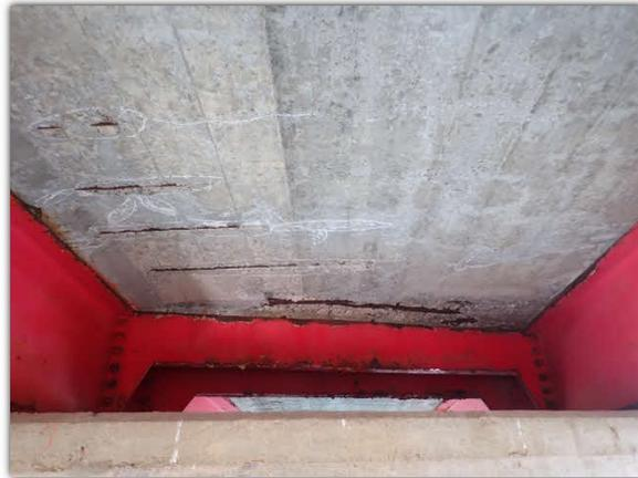
写真4. コンクリート床版の剥離・鉄筋露出
