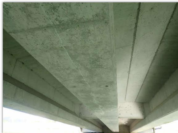
写真2. コンクリート桁のひび割れ・遊離石灰
