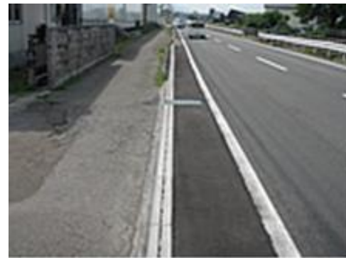
路側の改善（側溝の改修） 【出典：愛媛県】
