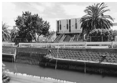
立岩排水機場
