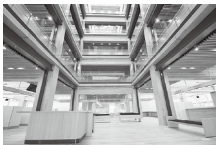
木造とRC造のハイブリット構造 長門市庁舎（山口県）
