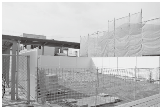
耐震化工事が進むJR鳴門駅舎
