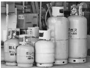
さまざまな避難所に設置されているLPガス
