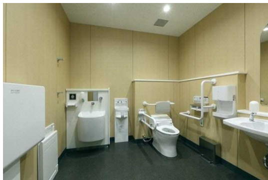
【多目的トイレ（愛西市HP）】
