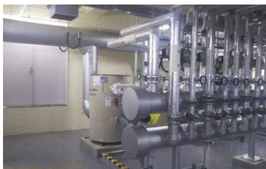
【余裕のある機械室（岩内町役場）】
