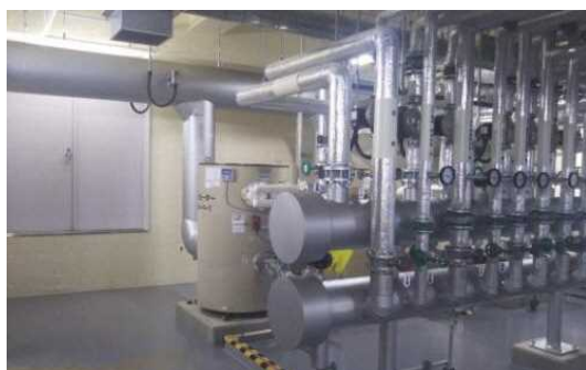
【余裕のある機械室（岩内町役場）】
