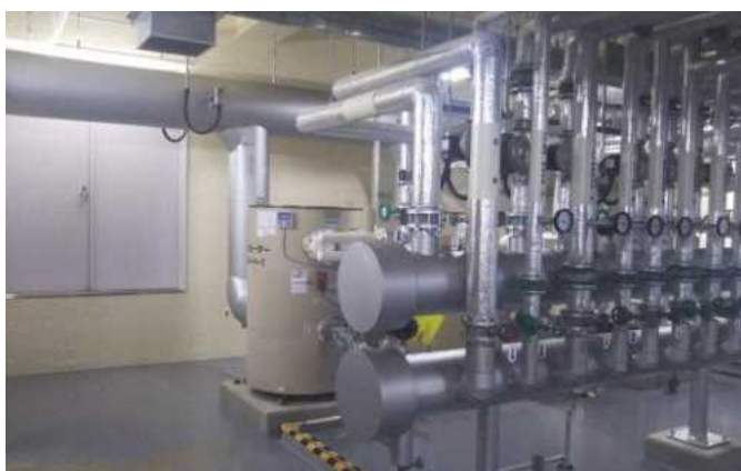
【余裕のある機械室 (岩内町役場)】
