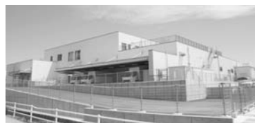
大津町に完成した学校給食センター
