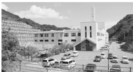
稼働後7年が経過したクリーンセンター
