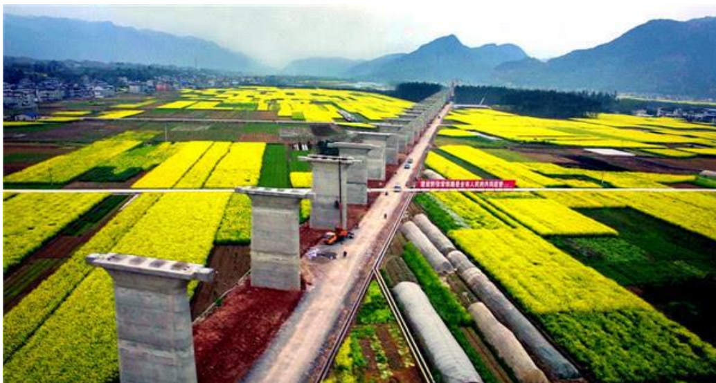
建設中の高速鉄道現場
