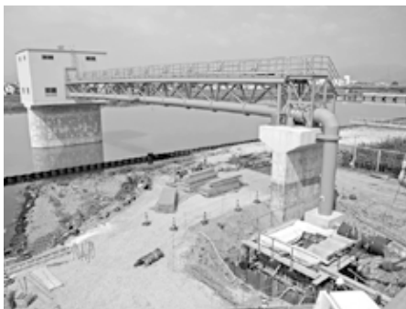
建設中の新しい取水施設
