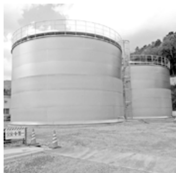
建設中の平草配水池
