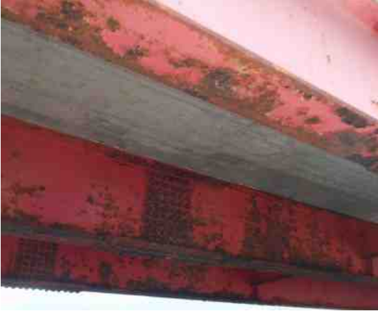
鋼材の腐食
