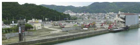
解体工事の様子【写真上／6月25日】【写真下／8月29日】
