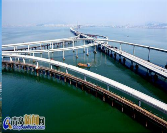
青岛跨海大桥
