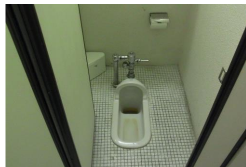
現状ホールのトイレの様子
