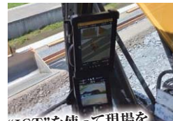
“ICT”を使って現場を効率化!そして休業日に!
