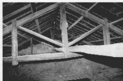
Dachstuhl einer ehemaligen Baracke
