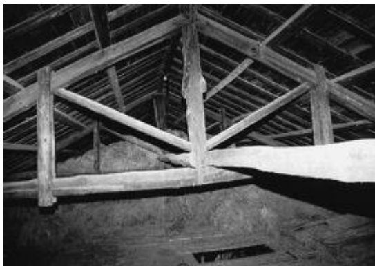
安芸宅の「旧バラック」の屋根裏部分
