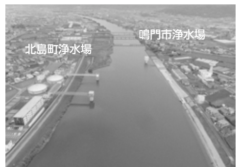
共同化を検討している浄水場
