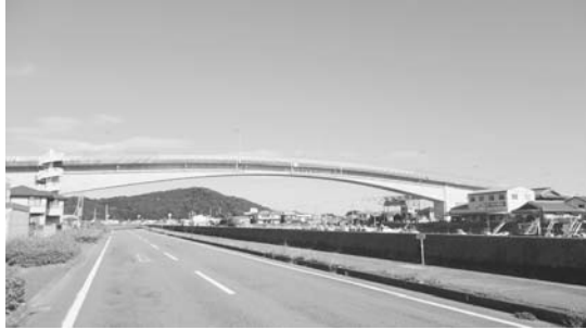
10橋中7橋が耐震化完了(撫養川大橋)
