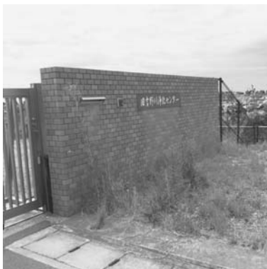
鳴門市の公共下水道に流される汚水が最後に到達する旧吉野川浄化センター
