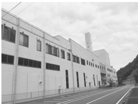
運用開始から8年が経過したクリーンセンター
