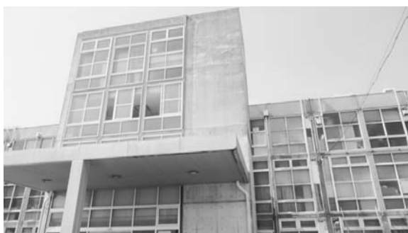
昭和38年竣工の鳴門市庁舎
