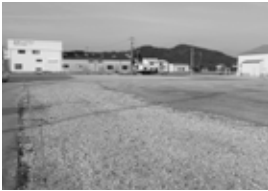
建物の解体撤去を終えた新学校給食センター建設予定地
