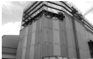
改築中の鳴門市第一中学校
