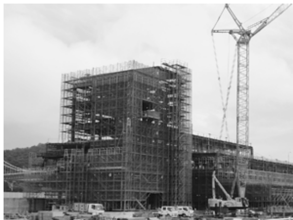
建設が進むポータルース鳴門新スタンド
