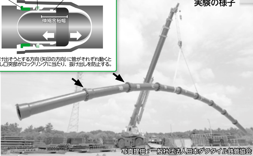
耐震管の吊り上げ実験の様子
