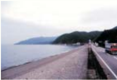
海辺(折野) 海岸沿いに国道 11 号線が走り、旧道を活かした「うずしおロマンティック海道」整備が進んでいる
