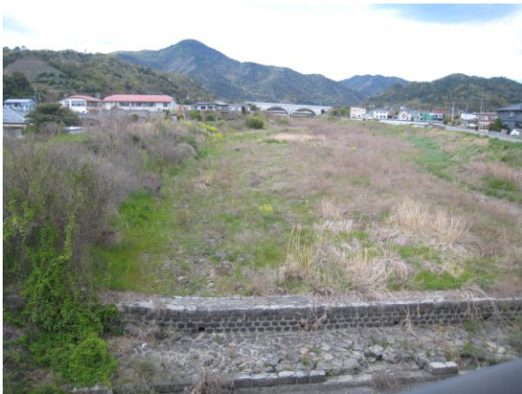
河川水が地下に浸透している板東谷川中流部
