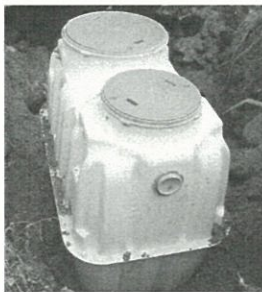
合併処理浄化槽
